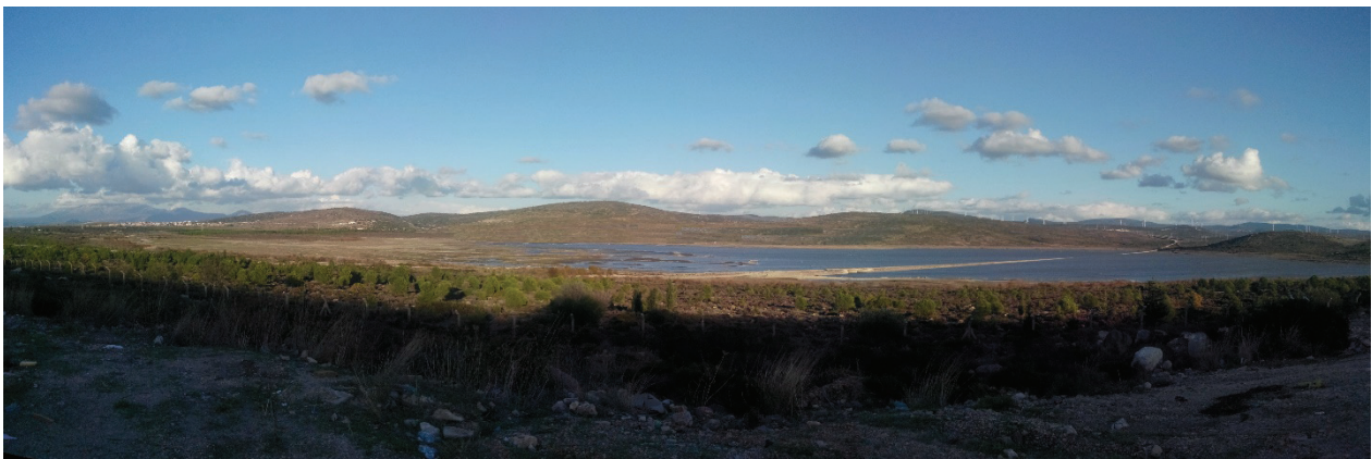
Figure 6. Picture from Alaçatı Kutlu Aktaş Dam
